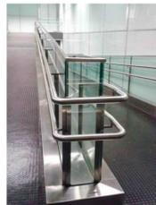
Imagem: exemplo de guarda-corpo com vidro laminado
