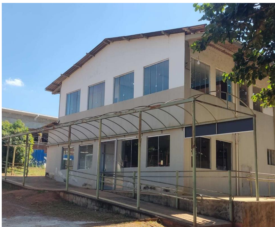
Estrutura metálica será removida
