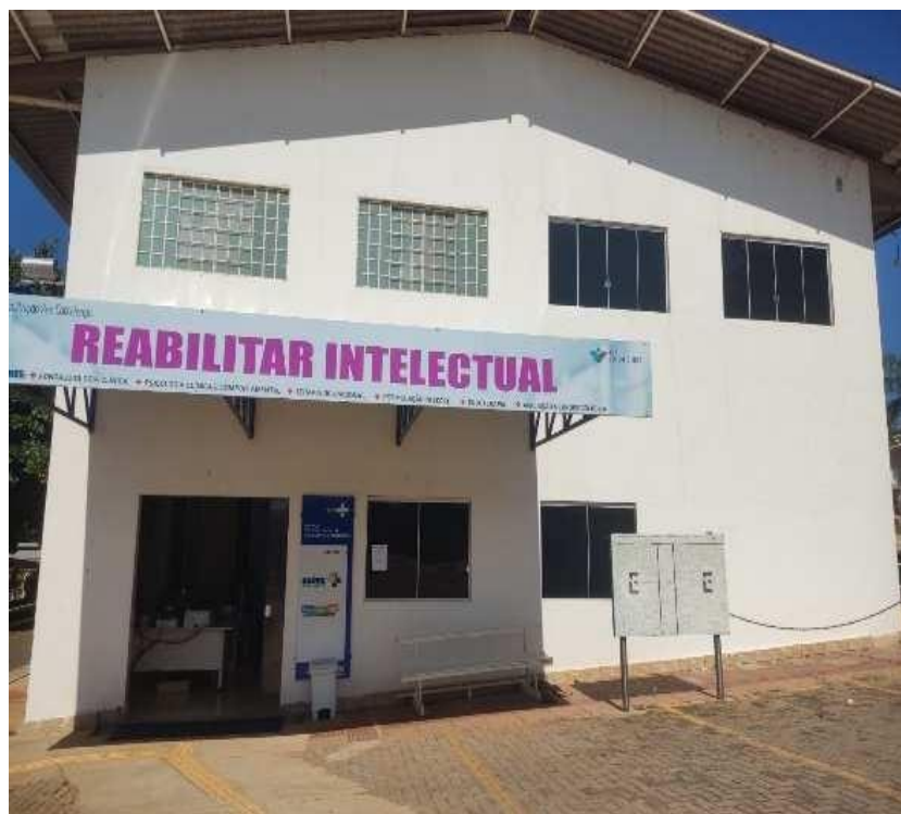
Fachada frontal terá adequações para melhorar o atendimento dos pacientes
