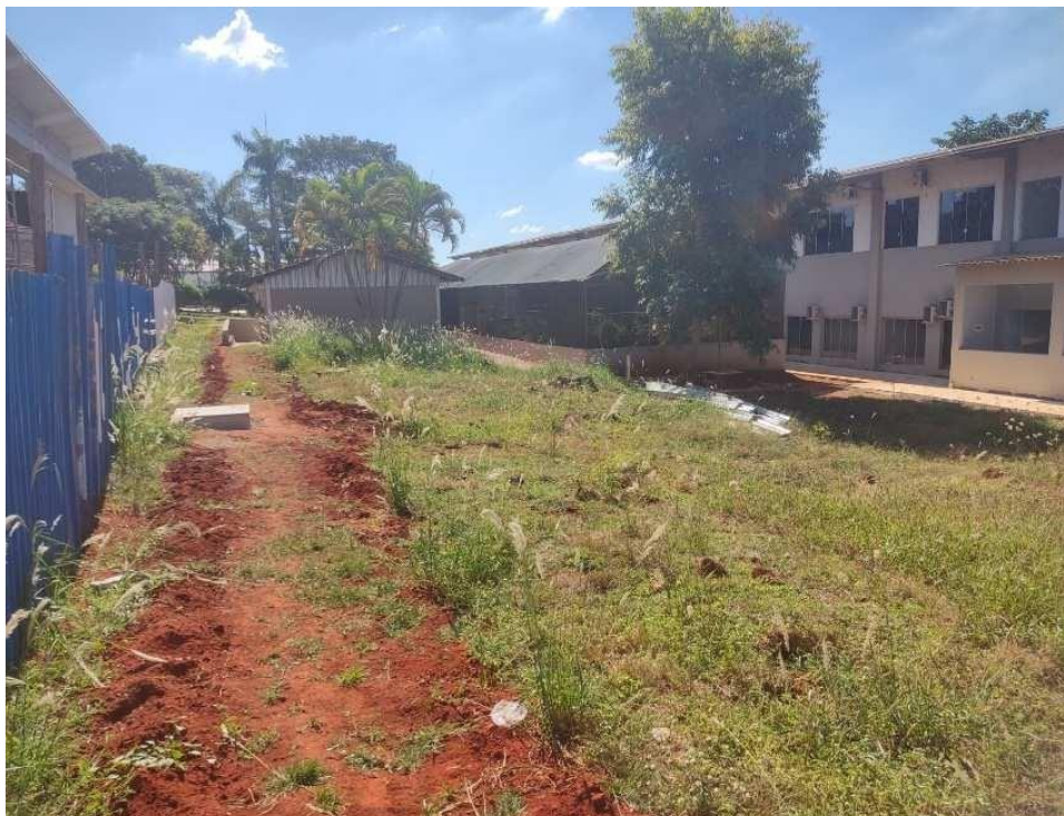
Regularização do terreno para o novo gramado do jardim
