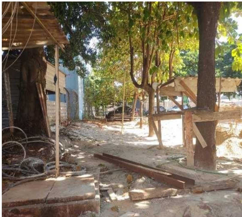
Área do novo estacionamento
