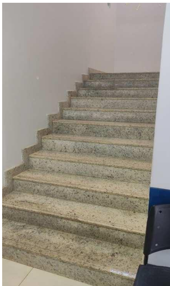
Reforma da escada de acesso ao 2º pavimento
