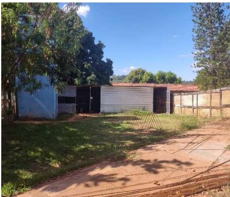
Demolição do depósito antigo
