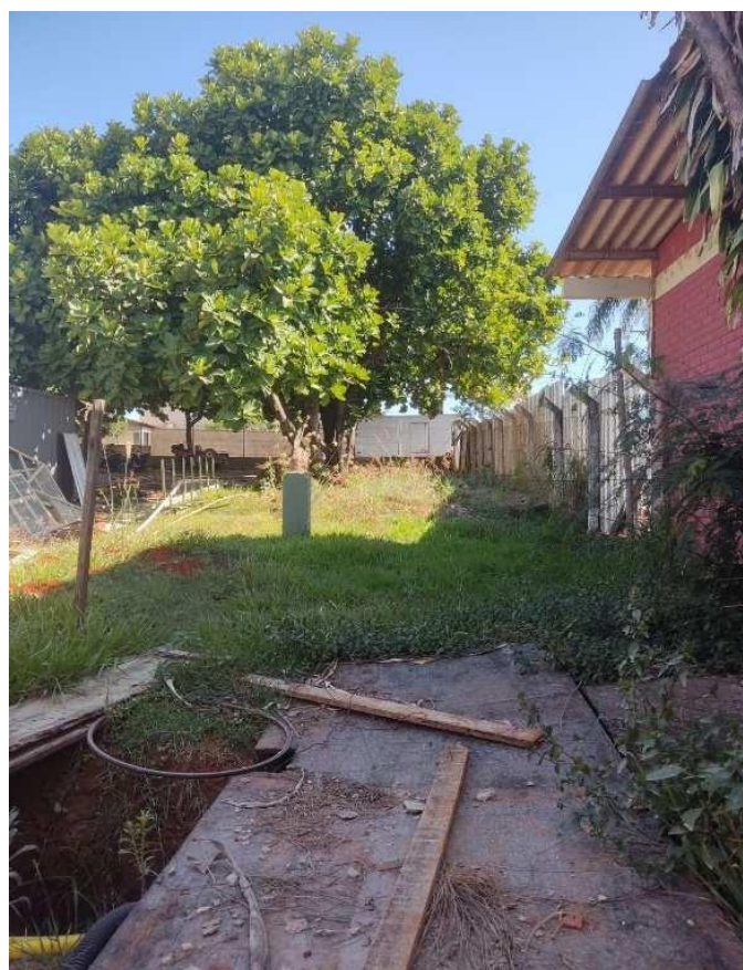
Regularização do terreno para as novas calçadas de acesso a edificação
