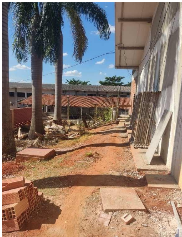
Será executada a calçada de acesso de colaboradores
