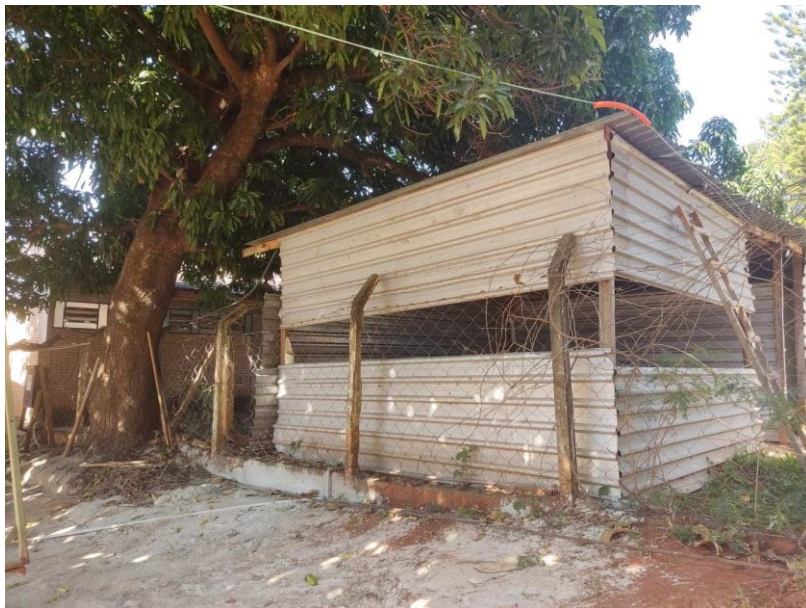
Demolição do barracão de obra antigo
