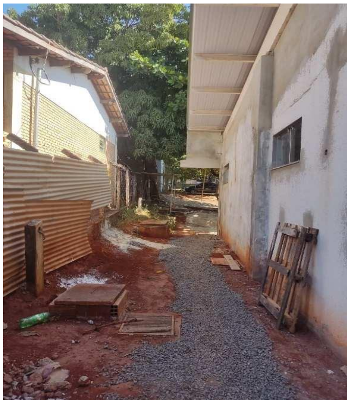
Adequação das caixas de inspeção para as novas calçadas
