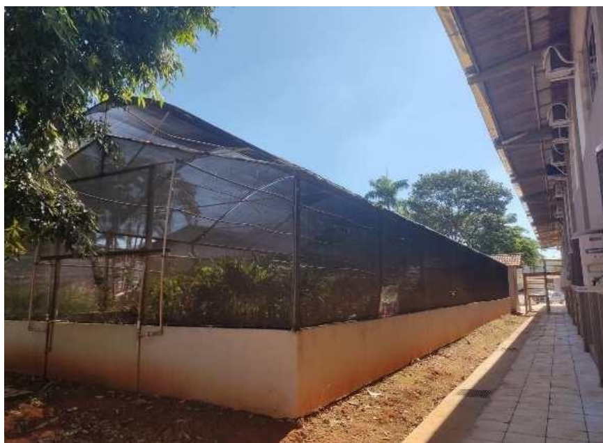
Demolição do viveiro
