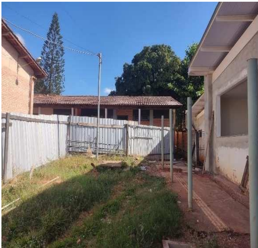
Demolição das calçadas e passarelas existentes
