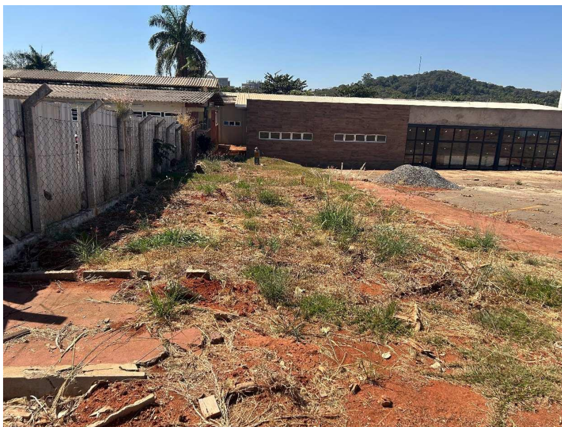
Demolição da calçada existente e regularização do terreno para as novas calçadas
