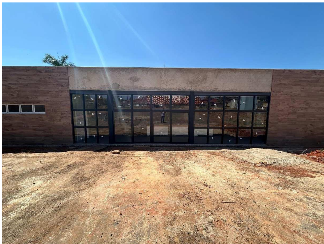
Local em que será realizado a marquise e pórtico.
