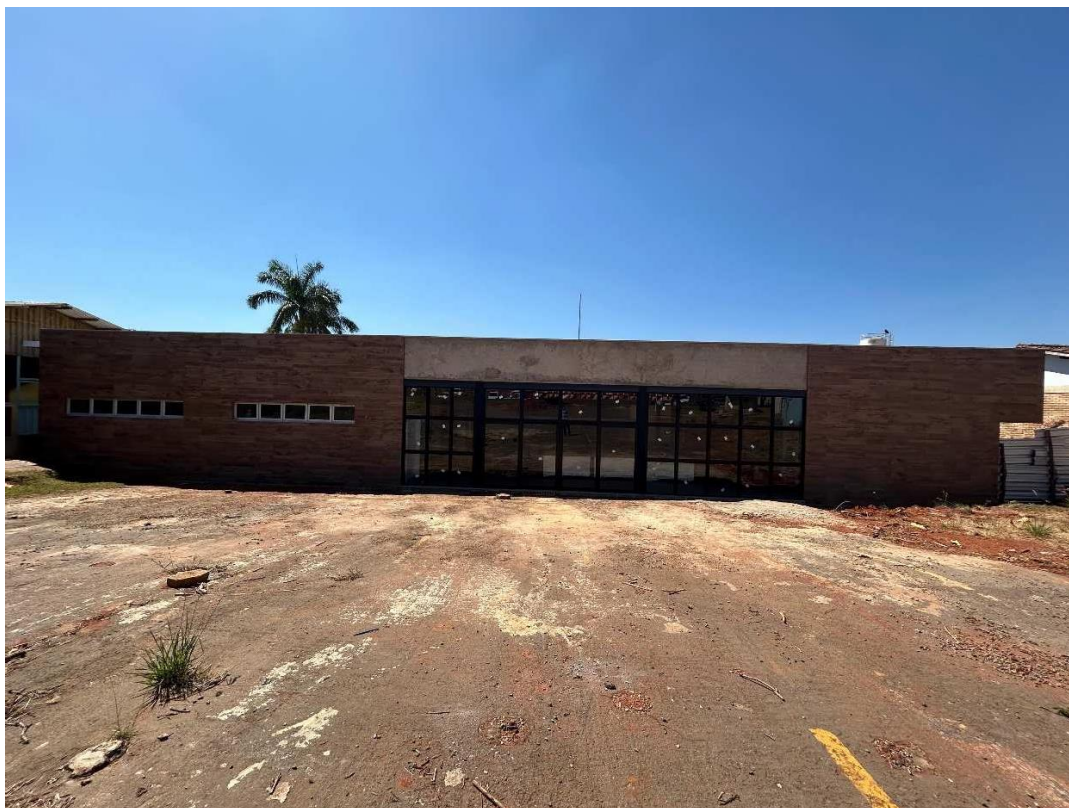
Atual situação da fachada do CER III.
