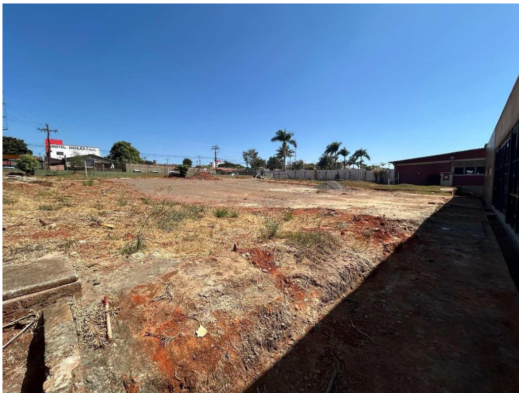
Movimentação de terra do local para o novo acesso a edificação.
