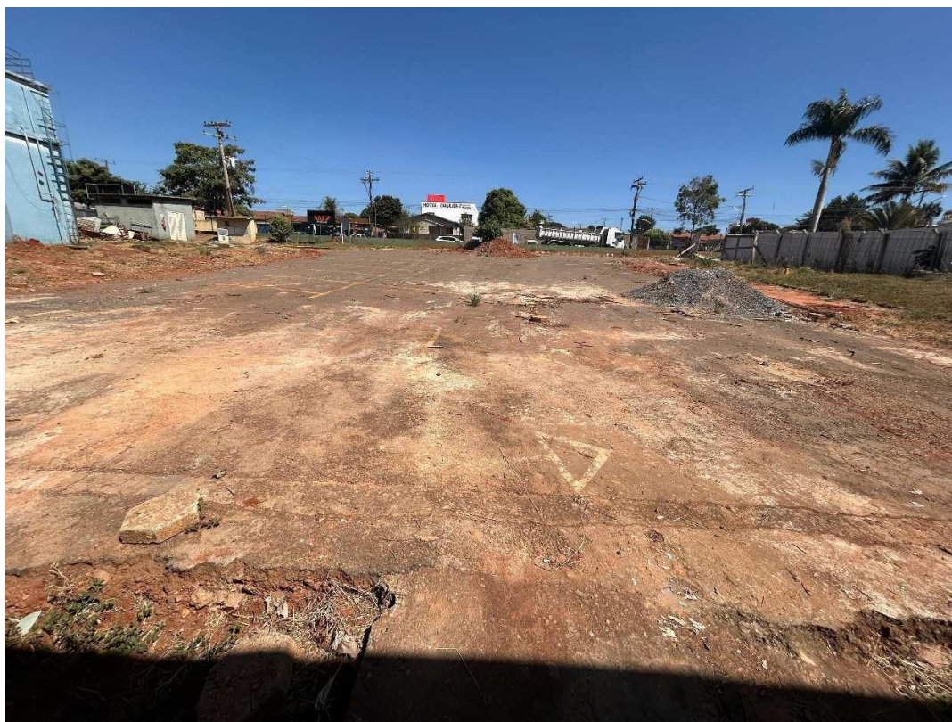
No local será feita a retirada do pavimento e novo nivelamento do terreno
