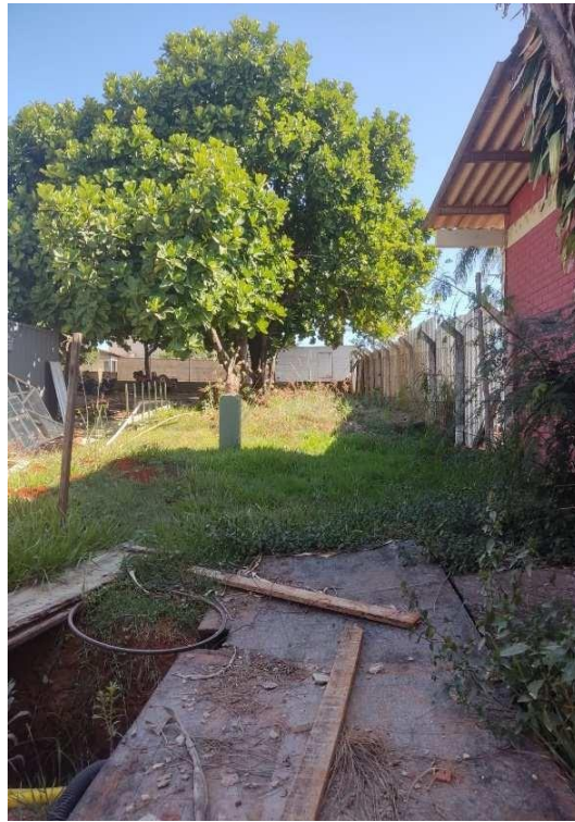
Regularização do terreno para as novas calçadas de acesso a edificação
