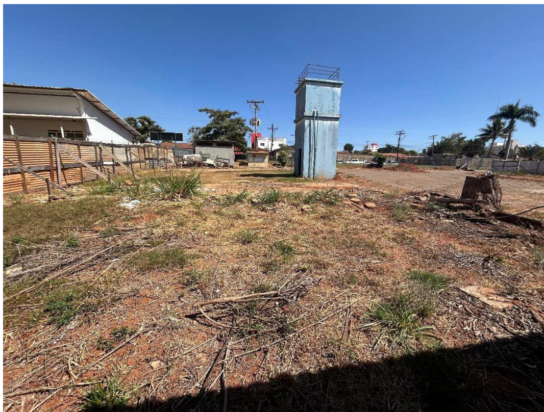
Demolição da capa de concreto, movimentação de terra e nivelamento do terreno para a nova área de estacionamento e acesso aos sanitários
