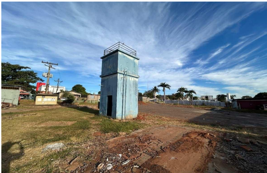
Regularização de terreno e retirada da capa de concreto.
